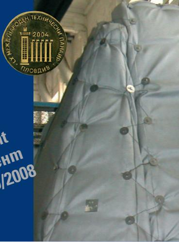
Многослойни топлоизолации за многократна употреба изработени от специални видове тъкани с широко приложение за изолация на арматура и други съоръжения със сложна форма без ограничения на размерите. Възможност за специални изпълнения при агресивни среди и температури до 1000 °C.
